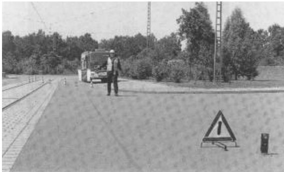
Sicherungsstellen an der Überführung einer elektrischen Leitung mit Schlauchbrücken
